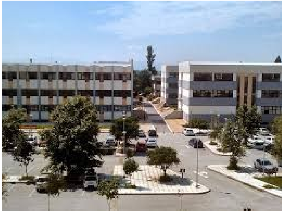
Εικόνα 1. Όψεις των κτιρίων του Τμήματος Οικονομικών Επιστημών, όπου στεγάζονται οι αίθουσες διδασκαλίας και τα εργαστήρια.
